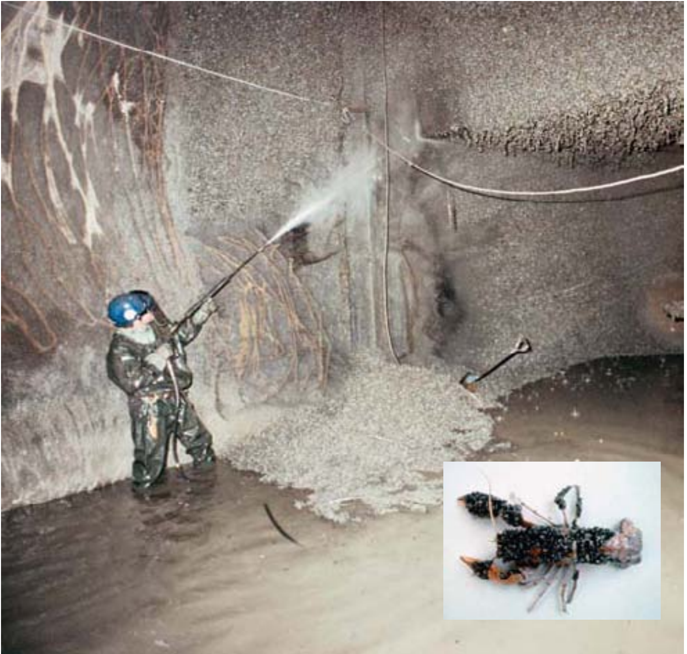
Un trabajador lanza chorros de agua caliente a los mejillones cebra que recubren el interior de una planta de tratamiento de agua en Michigan. (Imagen en recuadro) Mejillones cebra cubren el cuerpo de un cangrejo de río.
